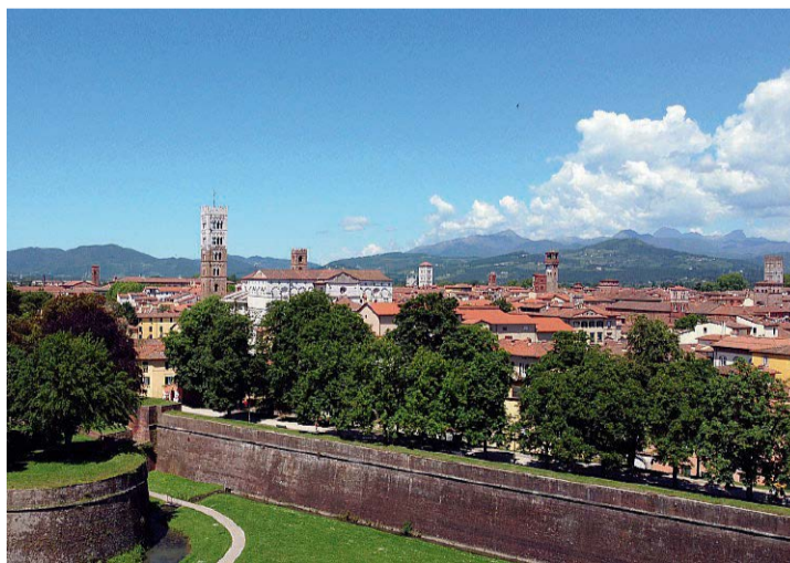
Le mura La cinta muraria cinquecentesca perfettamente conservata
